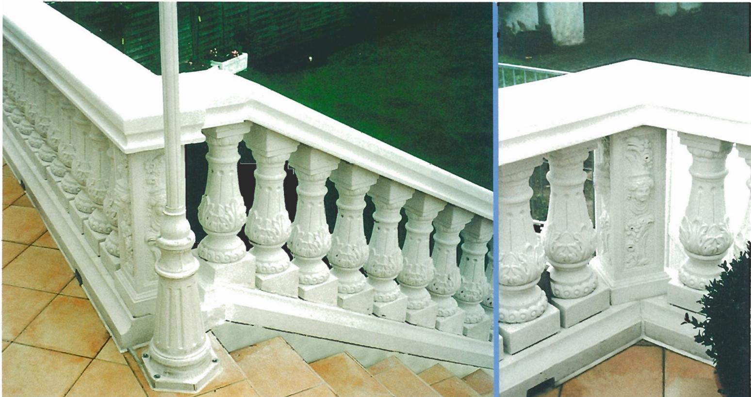
Balustrade mit 1 Baluster 110002 mit Sonderpfeiler, Fusslauf 110030 und Handlauf 110022
