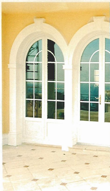
Fenster und Türeinrahmung mit Zierleiste 142114, Einsatzstein 143109, Kopfstein und Zierleistenbasis in Sonderausführung.
